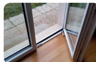
**La fenêtre oscillobattante possède deux systèmes d'ouverture : une ouverture à la française et une ouverture à bascule**
